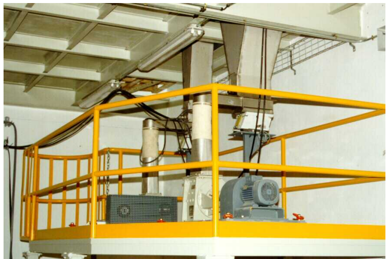
Molienda secundaria y alimentadores después del montaje inicial
