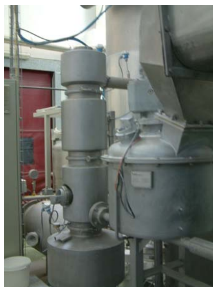
Estado actual. Depósito de alimentación y cámara de secado
